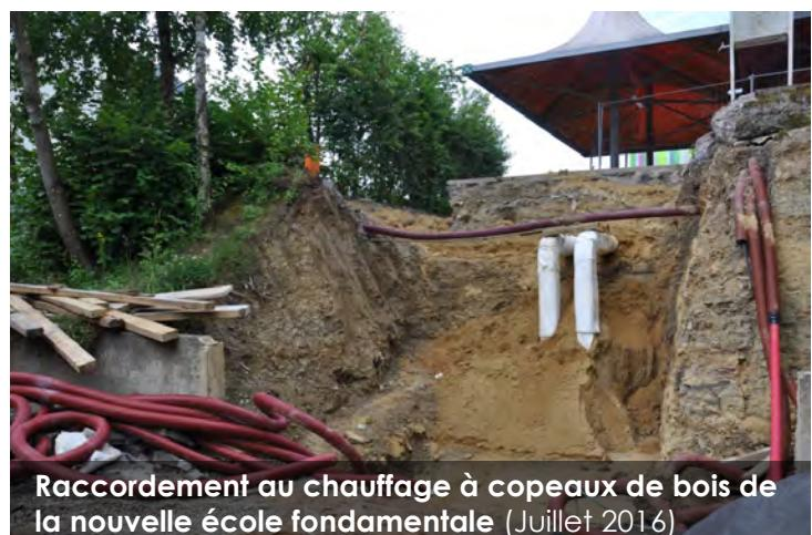
Raccordement au chauffage à copeaux de bois de la nouvelle école fondamentale (Juillet 2016)
