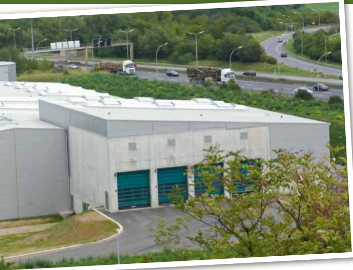
ne de l'installation de méthanisation 2011
