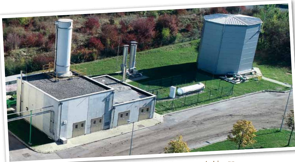
Die Gasaufbereitung · Épuration du biogaz
