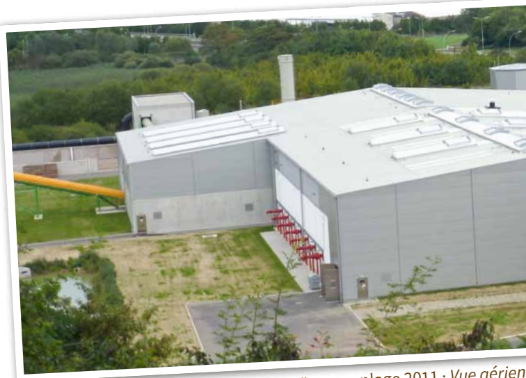
Ansicht Vergärungsanlage 2011 · Vue aérien
