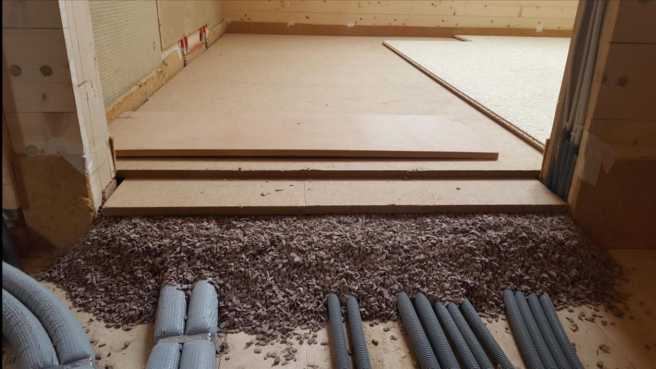
Trockenschüttung mit Holzspänen (Zement-ummantelt)
