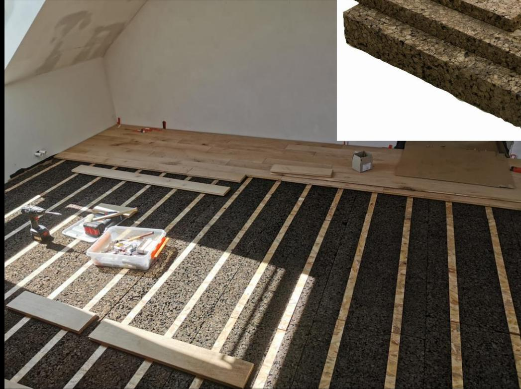
Dämmung Fußboden mit Kork (trittschall-entkoppelt)
