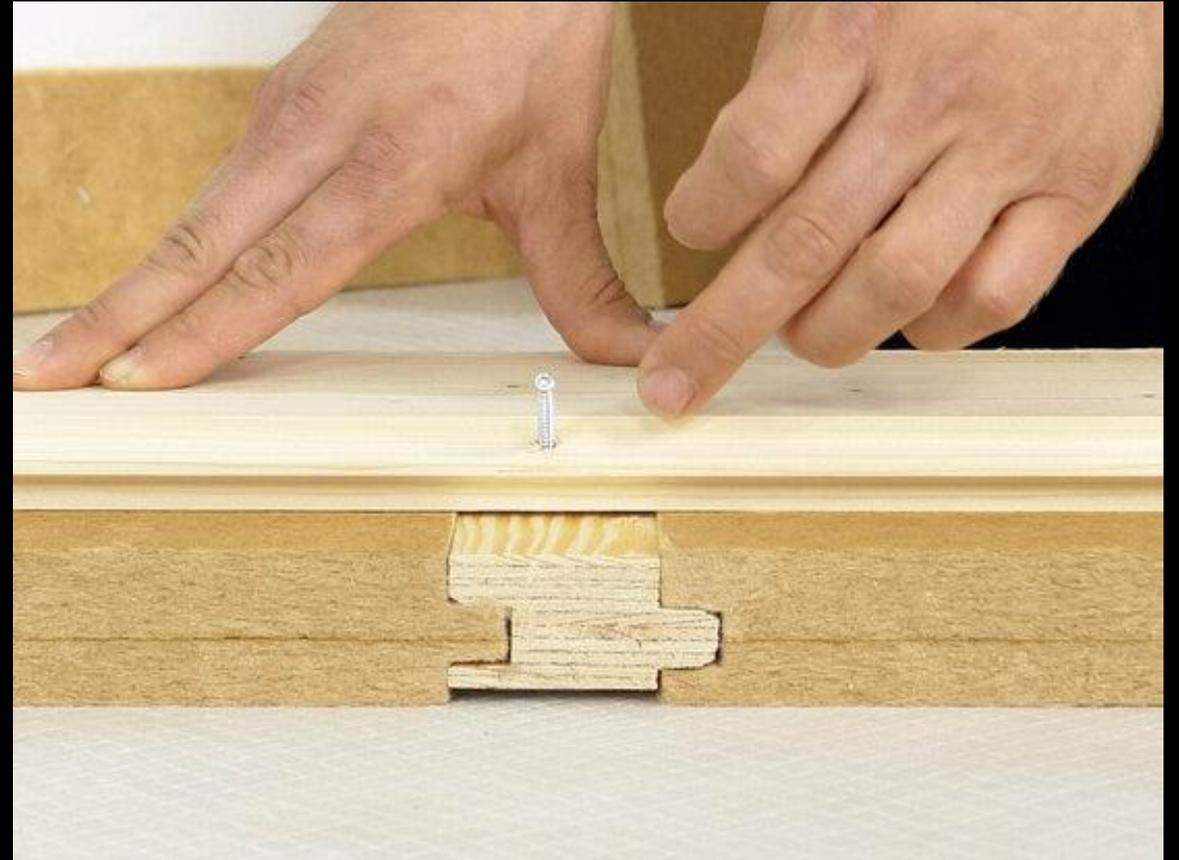
Dämmung Fußboden mit Holzfaser (trittschall-entkoppelt)
